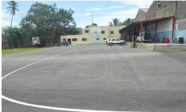
Asfaltado de la explanada de entrenamiento del CECCOM
