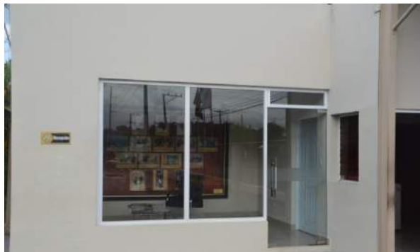
Construcción de la recepción del CECCOM
