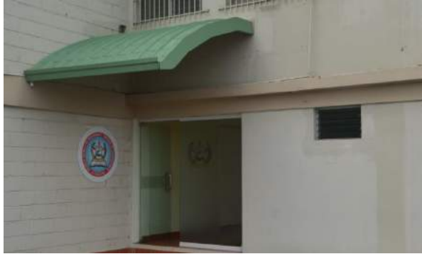
Construcción de la ESTCCOM
