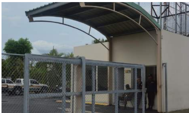
Construcción de la Casa de Guardia del CECCOM
