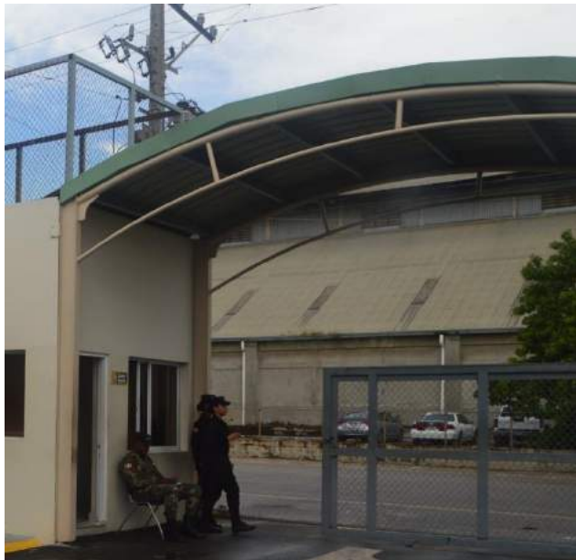
Construcción de la Casa de Guardia del CECCOM
