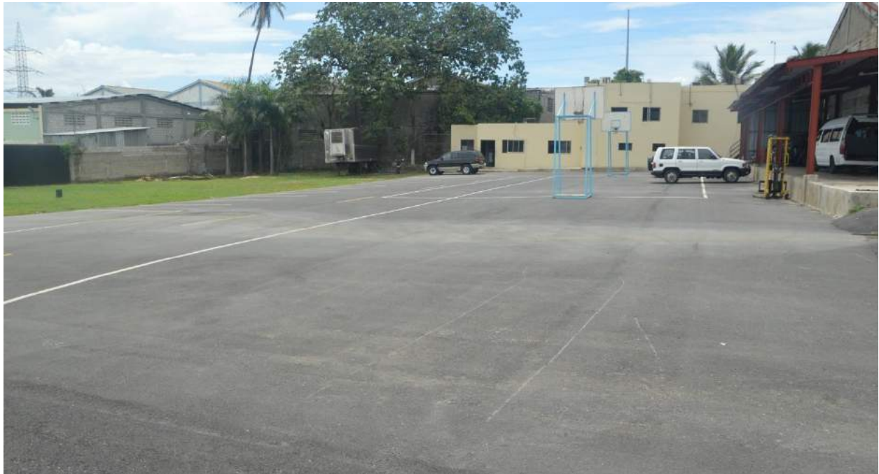
Asfaltado de la explanada de entrenamiento del CECCOM
