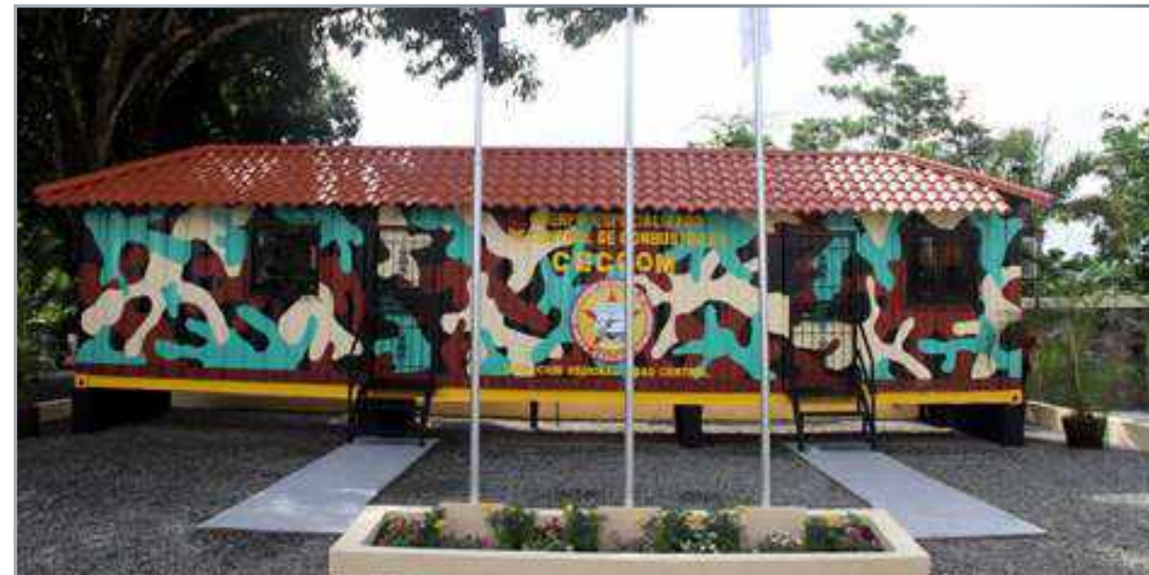
Remozamiento de gazebo y depósito la Dirección Regional Norte Puerto Plata.
